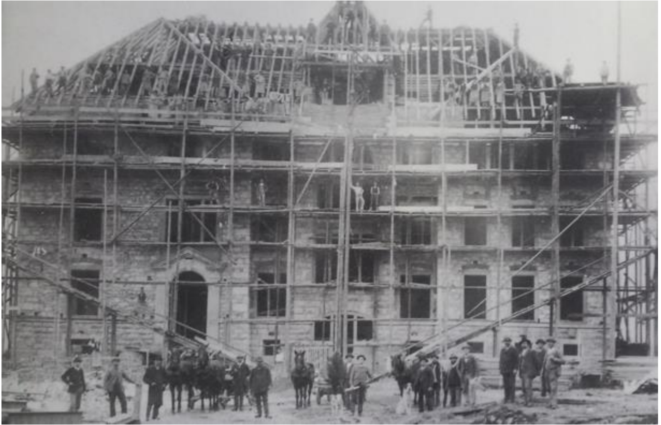
Bau des Kirchackerschulhauses, eingeweiht im November 1899
